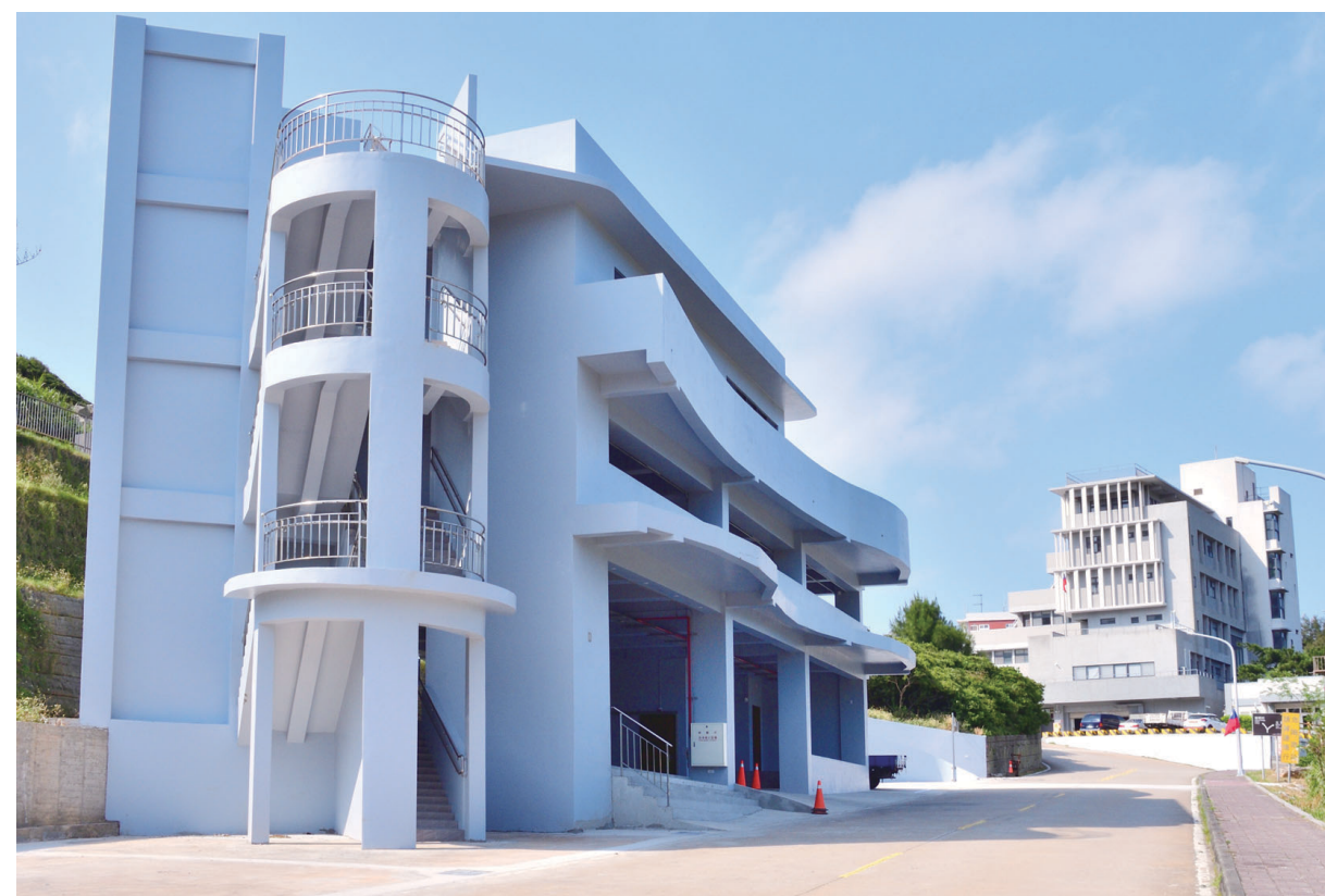
曾因施工進度落後而停工19個月的東引南澳休憩服務設施，經重新招標、復工後終於完成興建，目前進入驗收階段。（圖／文：陳其敏）
