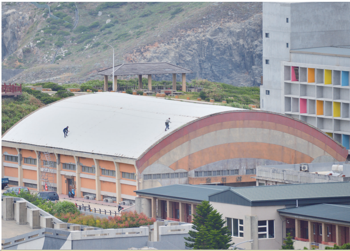
東引鄉體育館即日起配合屋頂改善工程全面封閉，施工期間暫停開放使用，鄉公所籲請軍民配合相關管制措施，避免進入施工區域，以維護安全。（圖／文：陳其敏）
