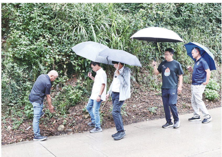
為改善梅石往清水路段泥沙沖刷至路面影響騎行安全的問題，議員曹以標、鄉代陳彥鈞邀集工務處長劉尚儒及環資局現地會勘，共商解方。（圖／文：王致潔）
