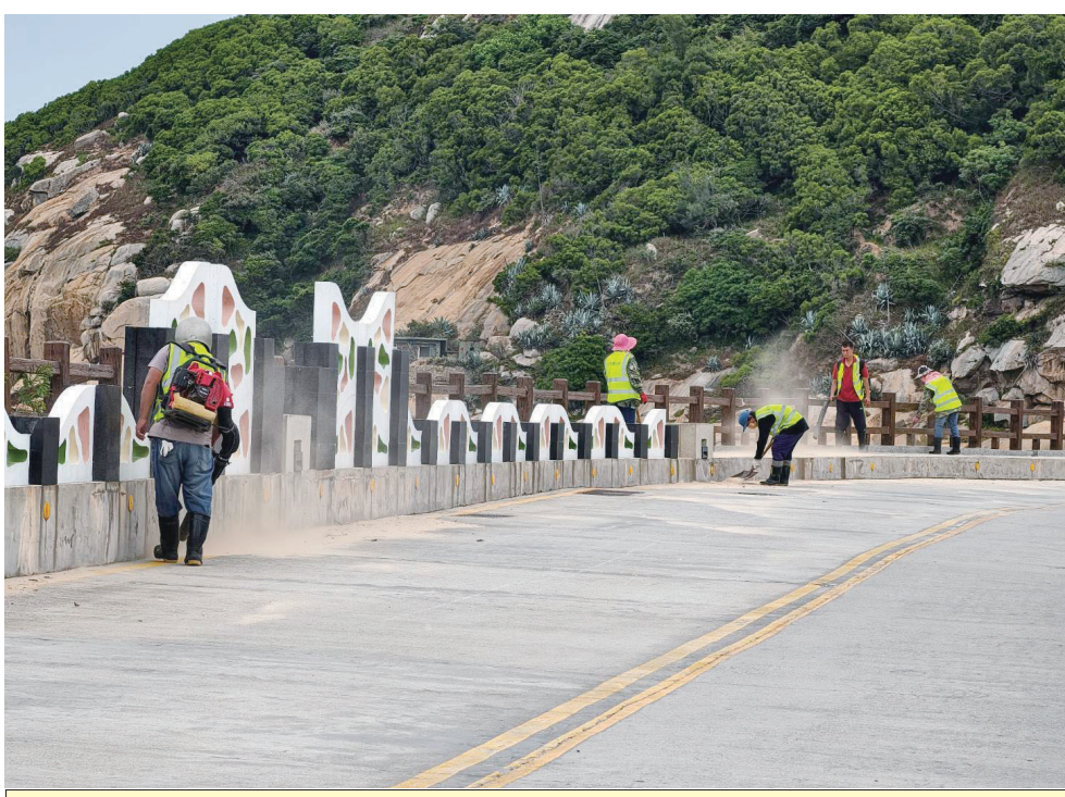
白海豚颱風遠離後，北竿鄉公所人員展開善後作業，清除路面樹枝、落葉及沙土，恢復道路及環境原有整潔。（圖／文：鄭禮頤）
