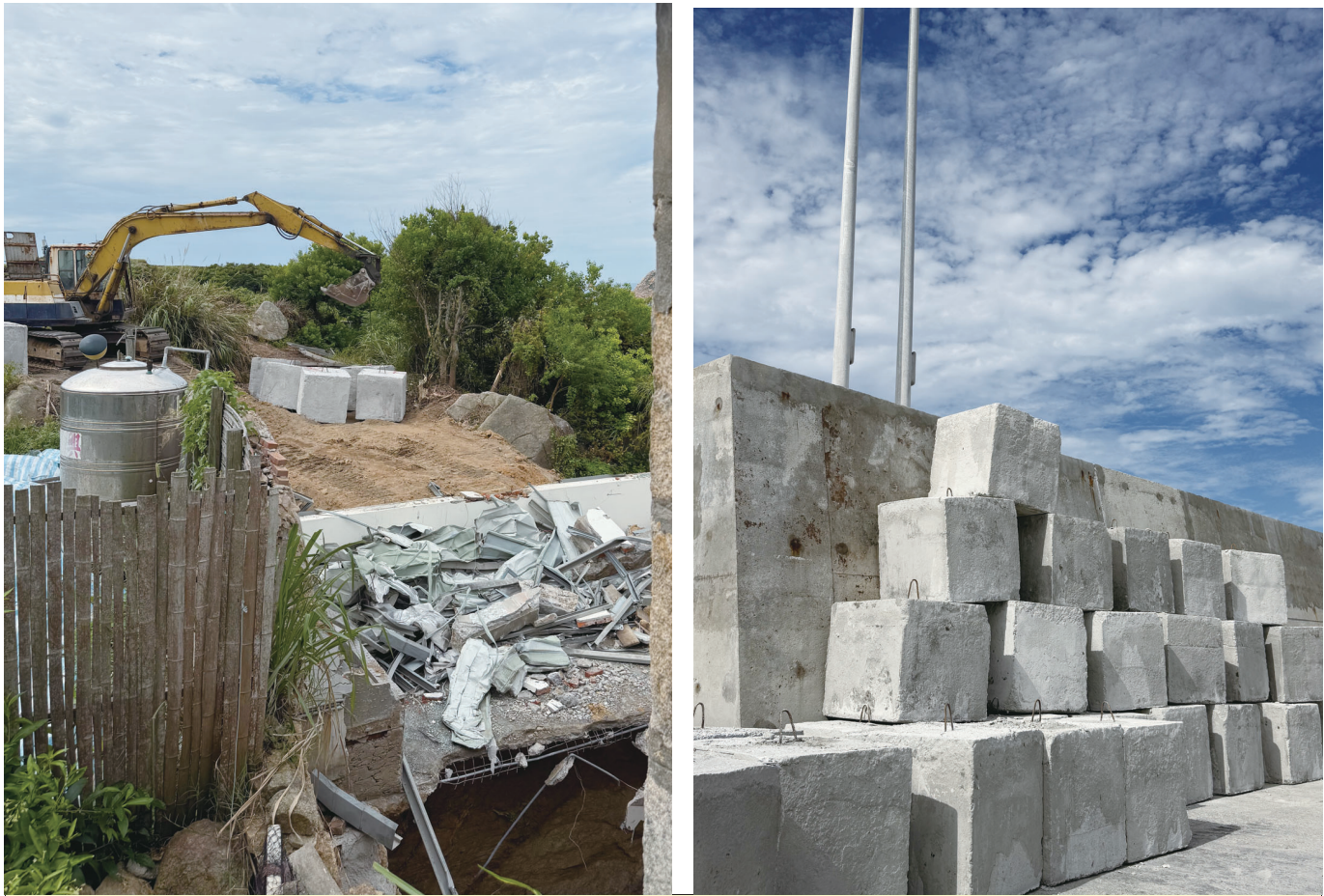
大浦聚落天坑搶災工程持續進行，第一批混凝土塊已於日前完成拋放，目前第二批混凝土塊陸續投入回填作業，後續材料也已提前規劃載運。（圖／文：蔡夢玲）
