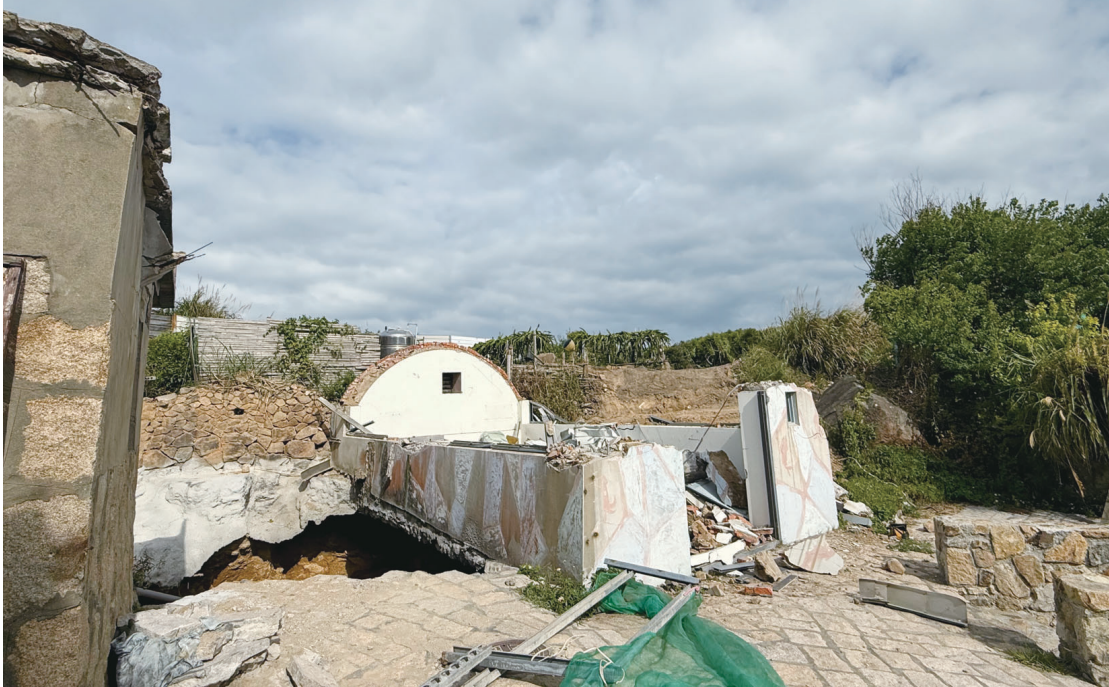
大浦漁寮配合大浦天坑搶災工程拆除。這座建築從早年漁民作業空間，到文化藝術場域，見證了大浦聚落走過不同年代的變遷。（圖／文：蔡夢玲）
