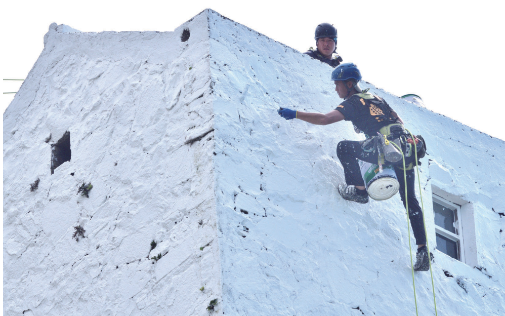
東引島燈塔景區油漆維護工程，施工人員採高空繩索作業方式進行外牆油漆塗刷，目前整體工程進展順利。（圖／文：陳其敏）
