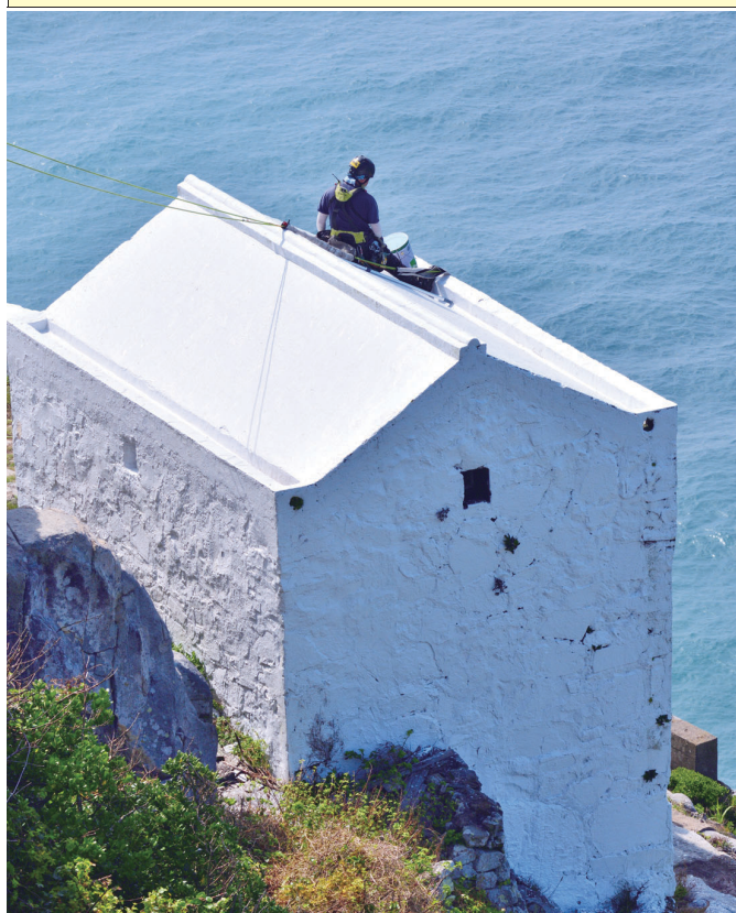
東引島燈塔景區油漆維護工程，施工人員採高空繩索作業方式進行外牆油漆塗刷，目前整體工程進展順利。（圖／文：陳其敏）
