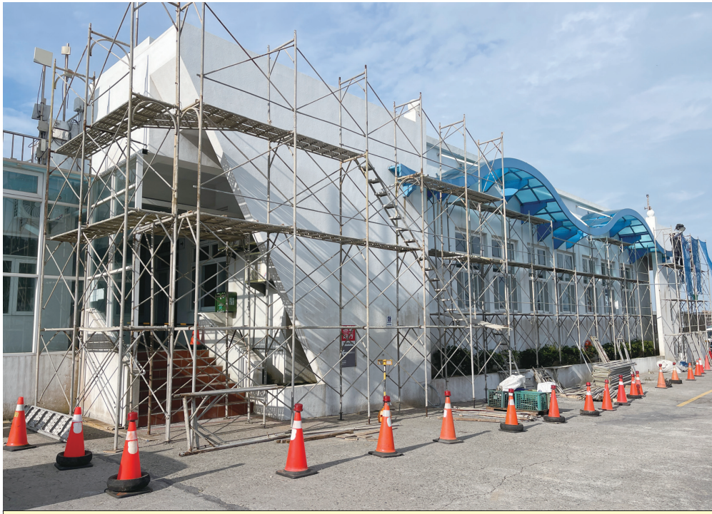
「115 年度連江縣客運碼頭(西莒)旅運安全設施改善工程」動工，港務處提醒旅客配合現場施工動線，留意自身安全。(圖/文：宋幸儒)
