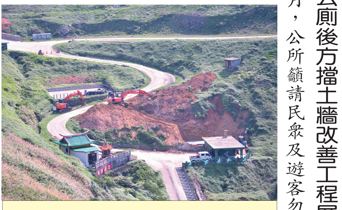
西引島清水澳公廁後方擋土牆改善工程展開，施工期間封閉施工區域，鄉公所籲請民眾及遊客勿進入。(圖/文：陳其敏)
