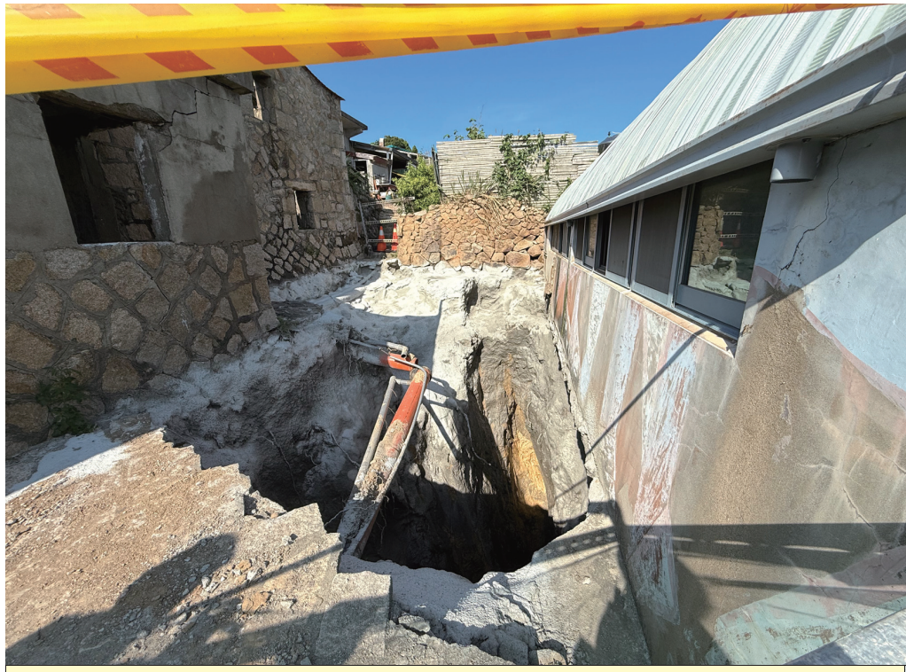
大浦聚落災害搶修作業持續進行，現場已完成邊坡噴漿作業，先行穩定受損區域。(圖/文：蔡夢玲)
