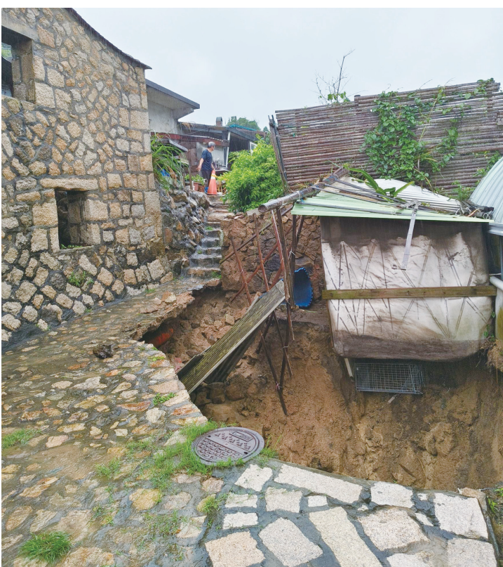
東莒大浦魚寮旁受連日豪雨影響，地基遭掏空形成坑洞，現場已拉起警戒線提醒民眾勿靠近。(圖/文：蔡夢玲、大坪村長鄭智新提供)
