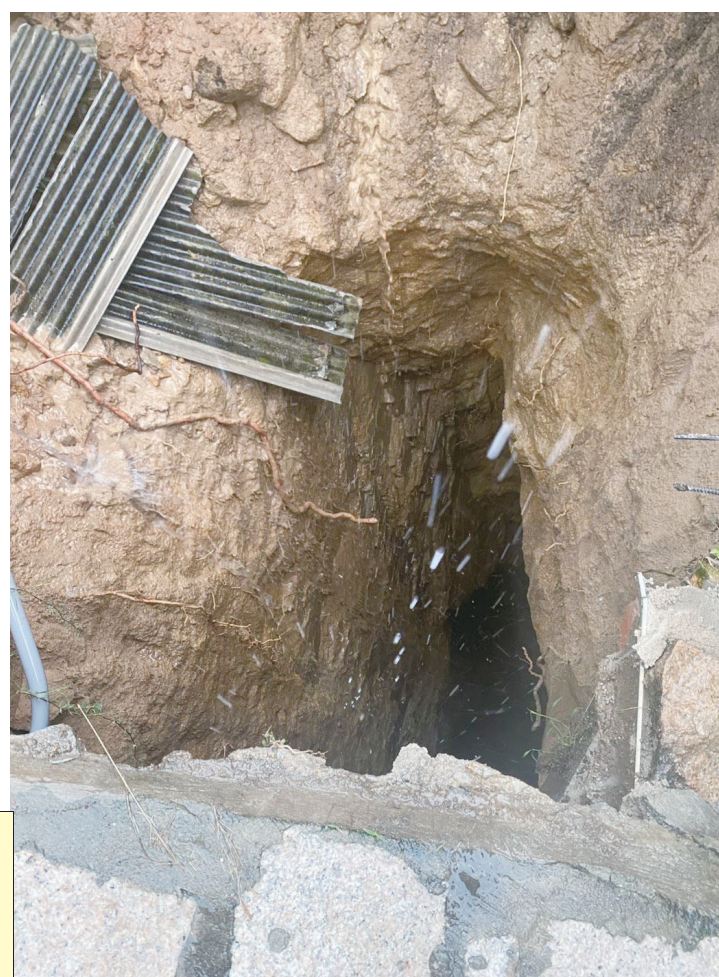
東莒大浦魚寮旁受連日豪雨影響，地基遭掏空形成坑洞，現場已拉起警戒線提醒民眾勿靠近。(圖/文：蔡夢玲、大坪村長鄭智新提供)
