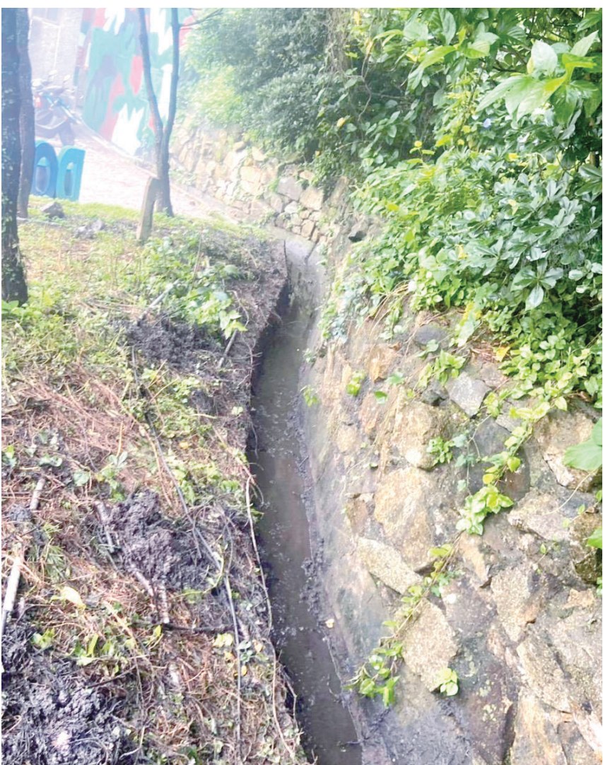
東引指揮部 22 日上午完成安東坑道旁水溝清理作業，原本堵塞造成污水外流的情況已排除，道路恢復正常通行。（圖：環資局）
