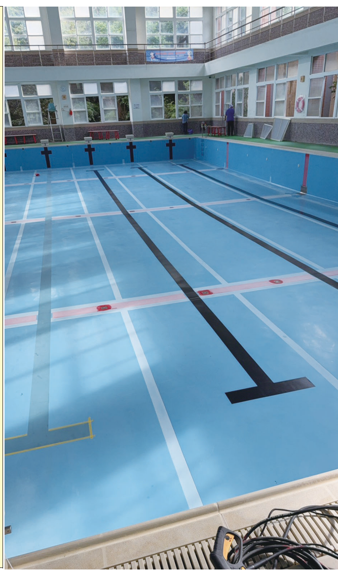
珠螺游泳池進行池底破損修補，預計於5月底至6月初開放。(圖：教育處)
