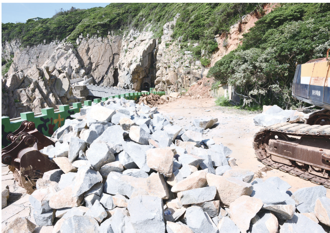
東引北海坑道施工區域已封閉管制，施工單位利用現地落石破碎填充蛇籠，強化邊坡穩定性。(圖/文：陳其敏)
