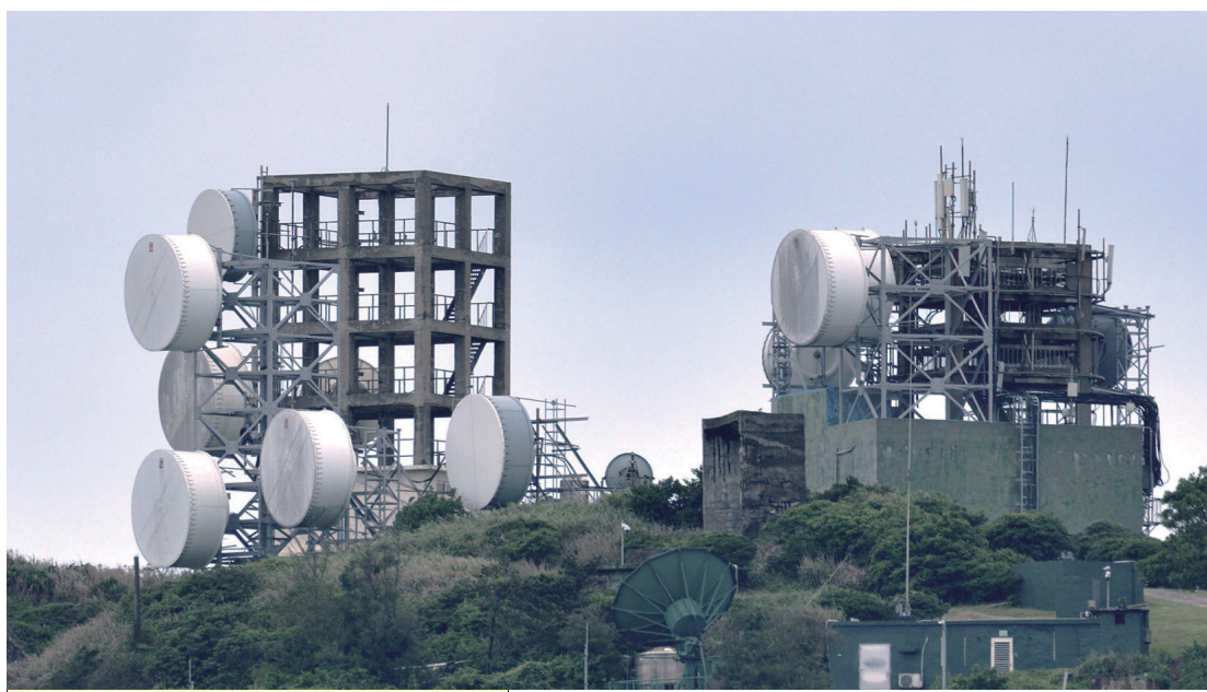
東引二重山的微波系統在斷起後，歷經多次增建擴充，中撐起統，歷經第二與第三海纜失效的定運作。（圖/文：陳其敏）
