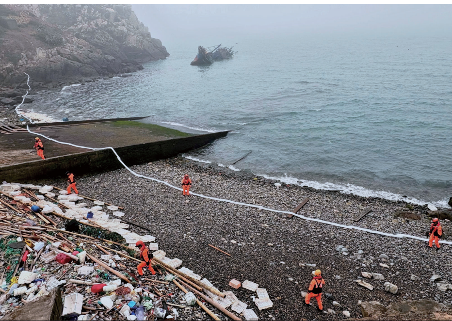
大陸漁船「閩連漁 63896」擱淺東引北澳口二天之後，23日上午，東引中柱安檢所岸巡人員於北澳口海域佈設攔油索，針對油污擴散情形進行應變。（圖／文：陳其敏）
