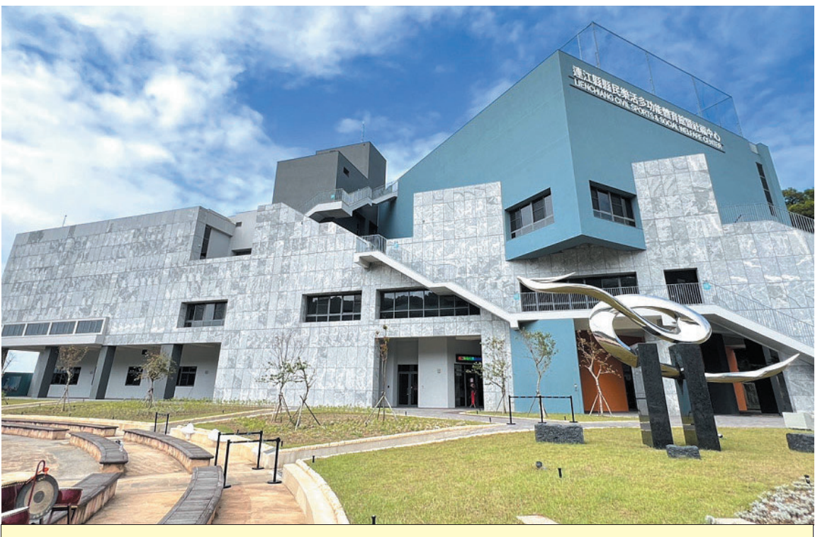
樂活館17日晚間已確認高壓用電設備故障原因並完成修復，昨日上午經台電測試無虞後送電，樂活館和南竿公托也正式恢復營運。(圖：本報資料庫)
