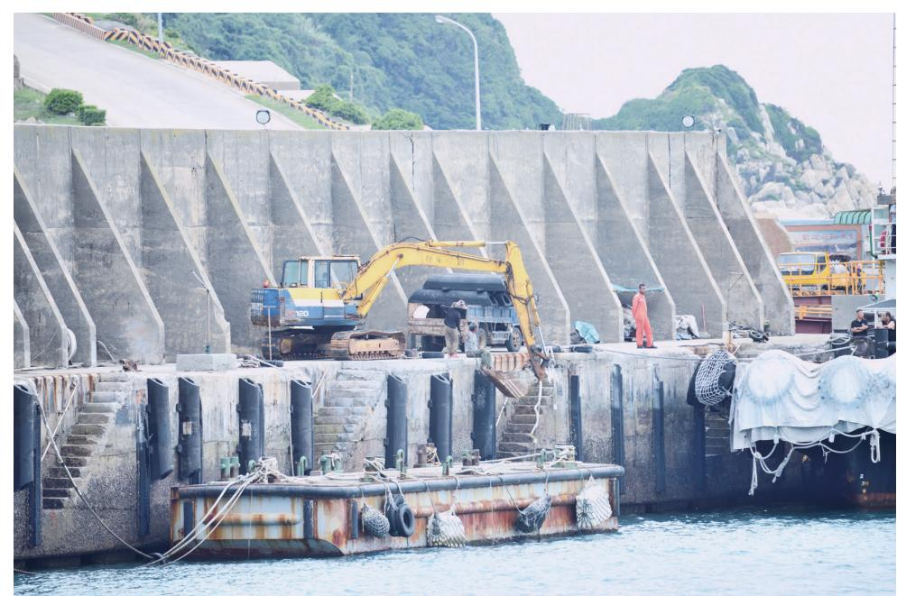
東引中柱港新臺馬輪停靠的碼頭區防舷材全部更新為尺寸一致護舷設施，拖船停泊的碼頭區，則透過新舊共用強化護舷設施功能。（圖／文：陳其敏）
