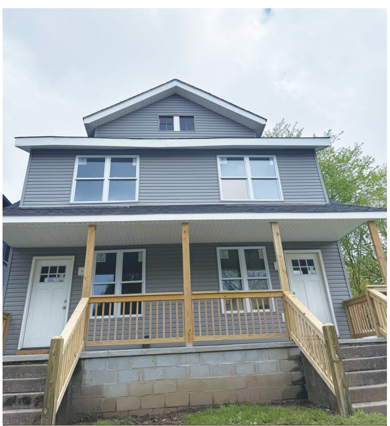
整修中的房子。
